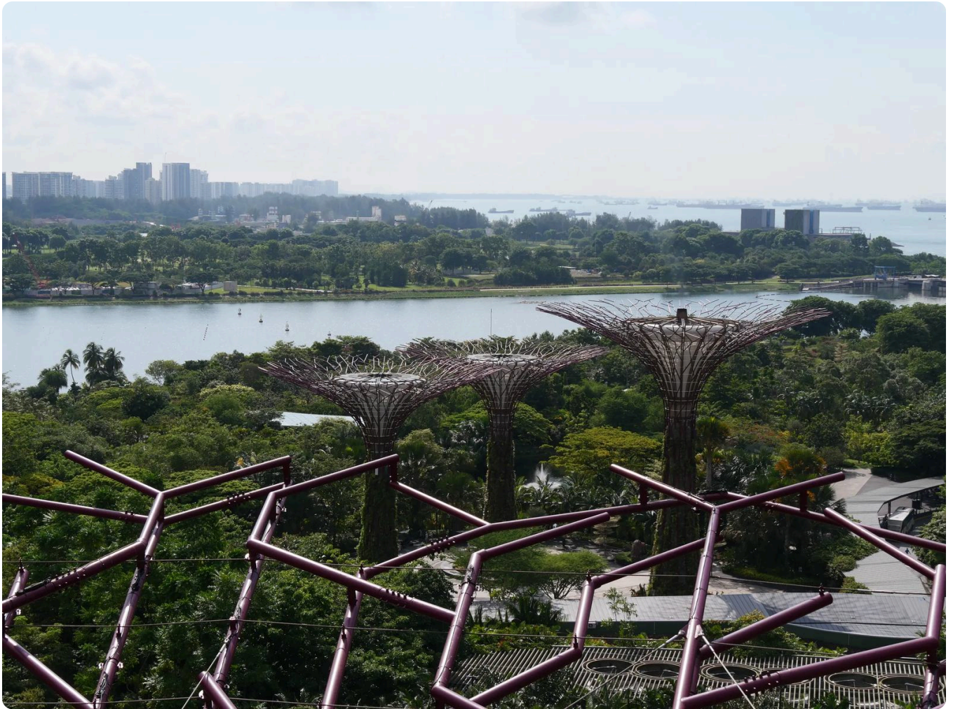
Passerelle et structure du Supertree Observatory
