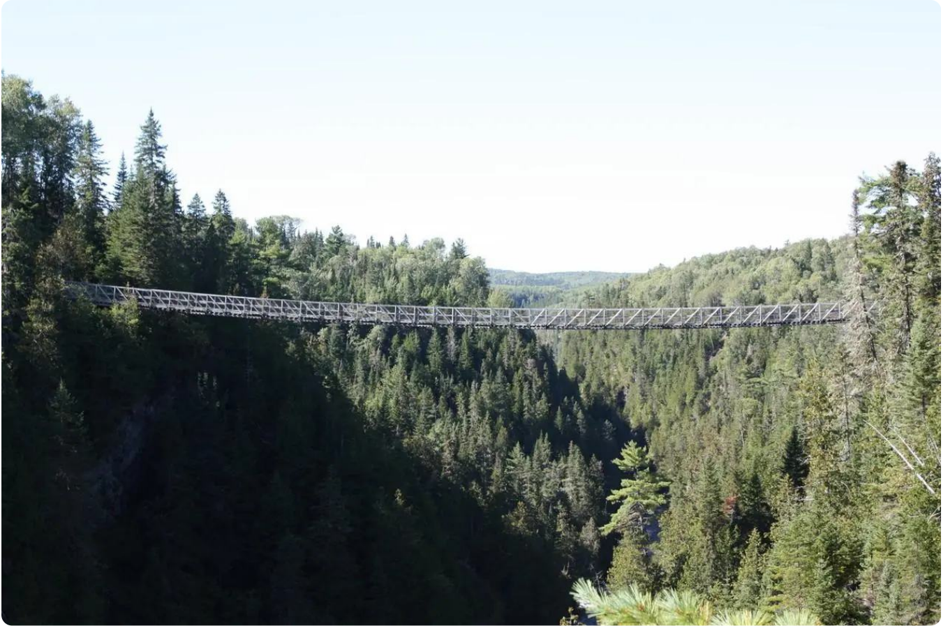
Passerelle suspendue du canyon
