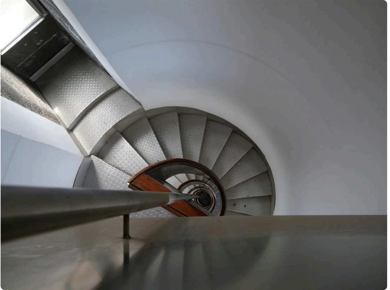
Escalier en colimaçon à l'intérieur du phare de Capelinhos
